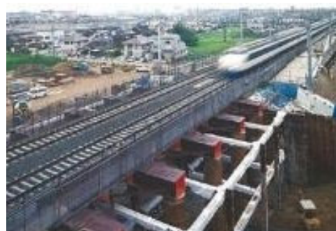
Tokaido Shinkansen Minowa Overpass
