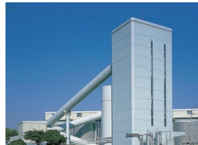
コンクリートプラント
