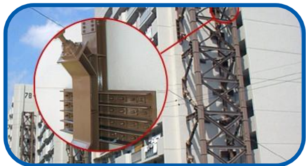
建物の耐震補強に・・
