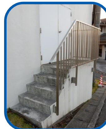
手すりの取付けに・・
