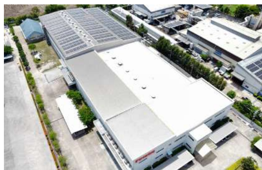
タイ工場全体の様子
