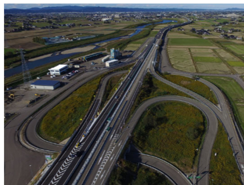
東海北陸自動車道 南砺舗装工事
