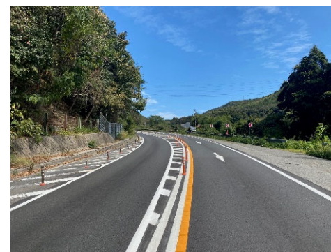
令和4年度西条維持出張所管内 舗装修繕他工事
