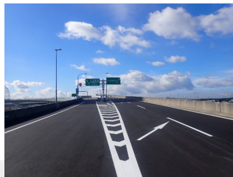
舗装補修大規模修繕工事 （2021-10-湾）
