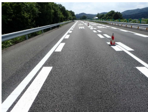
東北自動車道 宇都宮管理事務所管内 舗装補修工事
