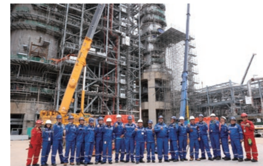
定期補修工事の様子
