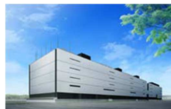
データセンター(館林)
