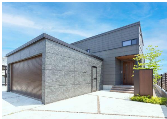
【カーヤード部門】
