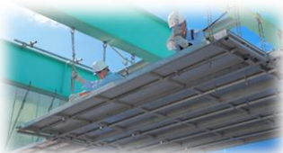
パネル式吊り棚足場 「SPIDER PANEL」
