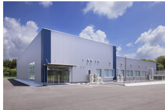
東京計器那須工場内 宇宙棟
