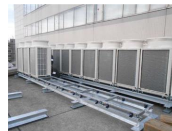
省エネルギー効果がある機器への更新工事
