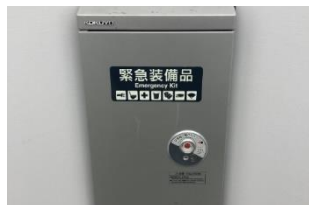
防災備品の設置
