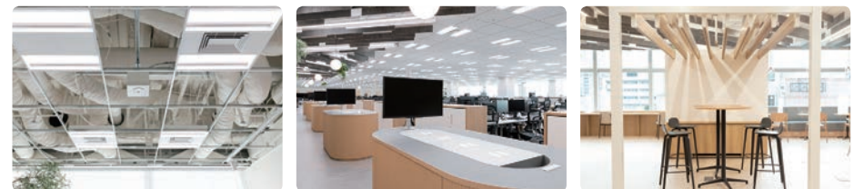
ダクトの増強工事を施し換気量を確保するとともに調湿機能も強化 床材や什器に抗ウイルスで天然素材のリノリウムを採用 清潔・快適な空気環境をつくるパナソニック社の「エアリーソリューション」
