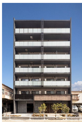
4. S-RESIDENCE 本所吾妻橋
