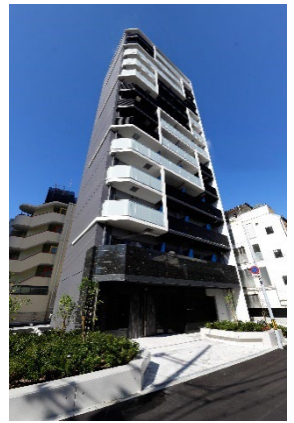
36. S-RESIDENCE 福島玉川 Uno
