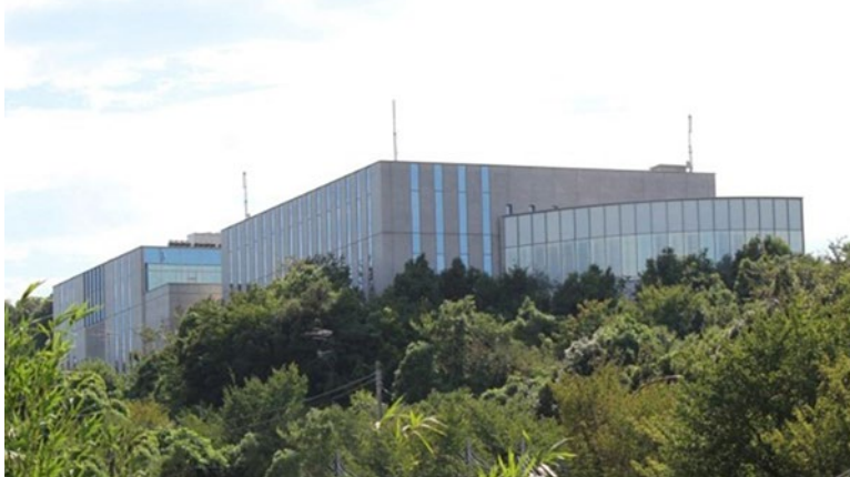
アイネット第1データセンター
