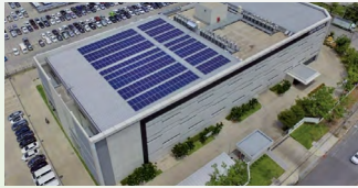
タイのR&Dセンター屋上に設置した太陽光パネル
