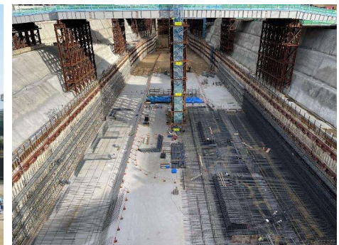
神奈川県駅（仮称） 鉄筋工
