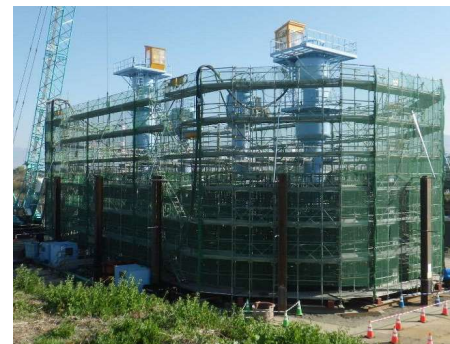
笛吹川・濁川橋りょう 橋脚工
