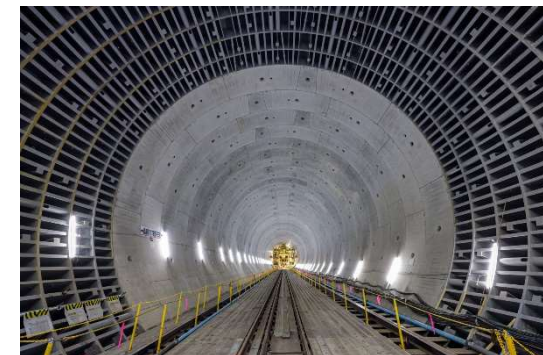
第一首都圏トンネル 東百合丘工区
