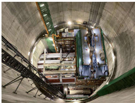
第一中京圏トンネル（名城工区） シールド掘進準備工
