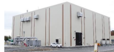
女川原子力発電所 緊急時対策建屋
