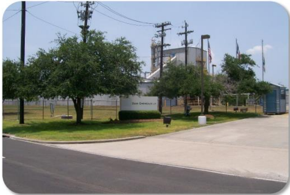
Zeon Chemicals テキサス工場
