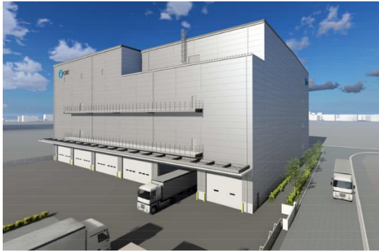
42 ロジスクエア厚木南 2025年10月末竣工予定 ※パースはイメージであり、今後変更となる可能性がございます。
