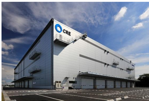
13 ロジスクエア春日部 2018年6月竣工
