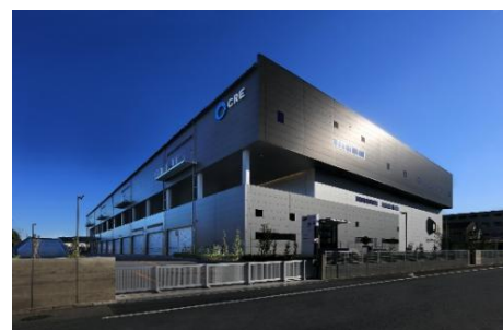
22 ロジスクエア白井 2022年12月竣工
