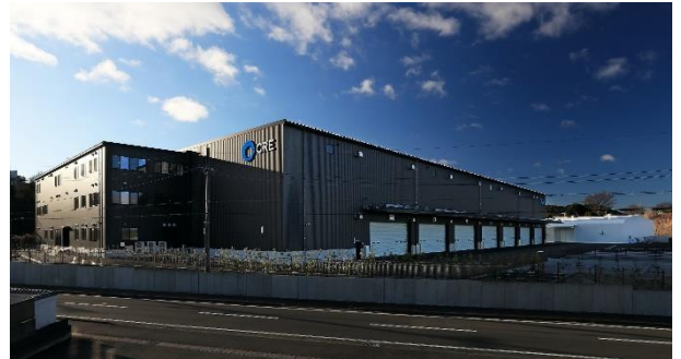
28 ロジスクエア掛川 2024年1月竣工
