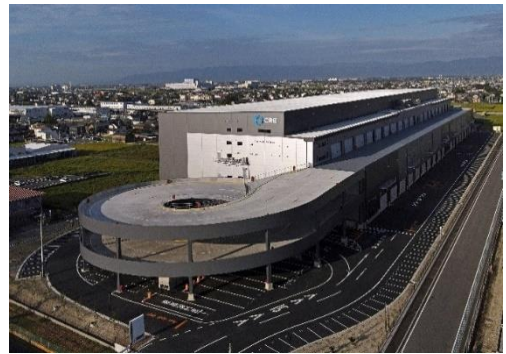
26 ロジスクエアー宮 2023年9月竣工
