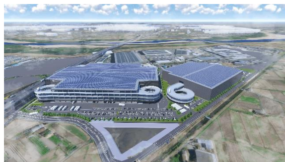
33 ロジスクエア京田辺A 2025年2月竣工予定 34 ロジスクエア京田辺B 2026年竣工予定
