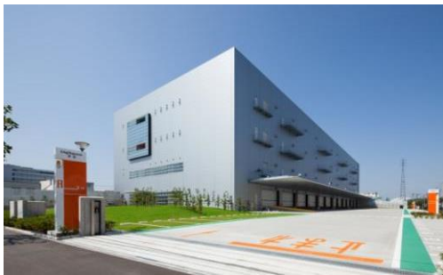
1 ロジスクエア草加 2013年6月竣工
