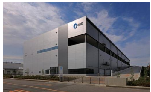
4 ロジスクエア久喜 2016年6月竣工
