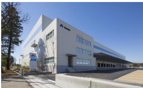
3 ロジスクエア日高 2015年3月竣工
