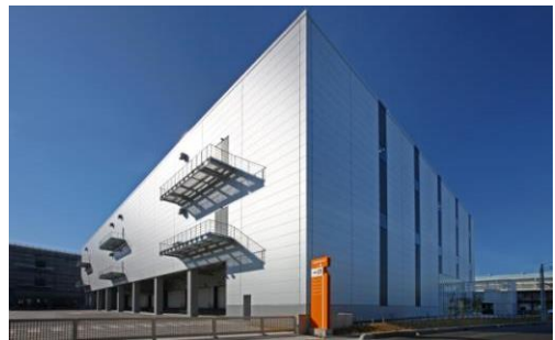
2 ロジスクエア八潮 2014年1月竣工
