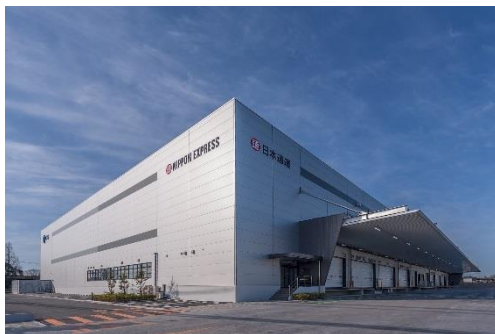
11 ロジスクエア鳥栖 2018年2月竣工
