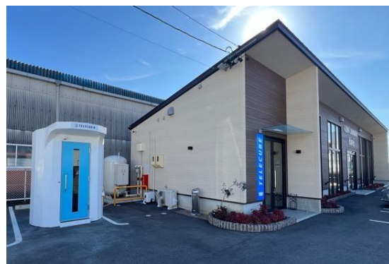
<製品設置写真（愛知県安城市）>
