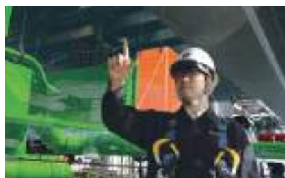
現物とBIMを重ねて表示し施工位置を確認(BIM活用)
