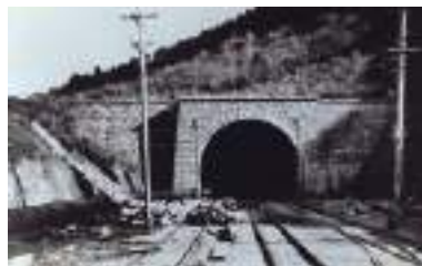
丹那トンネル(1934年完成/静岡県)
