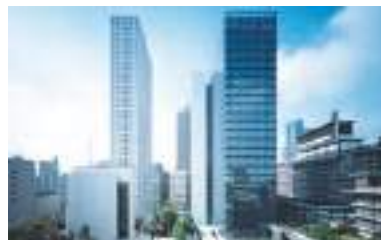
虎ノ門タワーズ(2006年完成/東京都)
