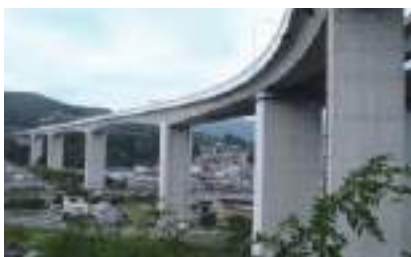
長野自動車道 岡谷高架橋 (インフラ更新)
