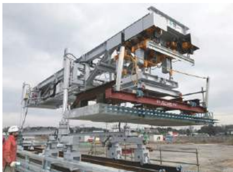
SDRシステム実証実験風景。プレキャスト床版を設置するマシン
