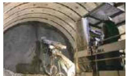
吹付作業の自動化施工 (神岡試験坑道)
