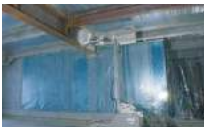
耐火被覆吹付ロボット(スマート生産技術)
