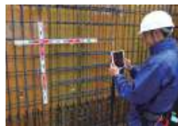
One Team による配筋検査
