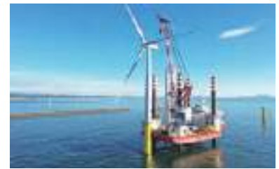
秋田港・能代港洋上風力発電施設建設工事
