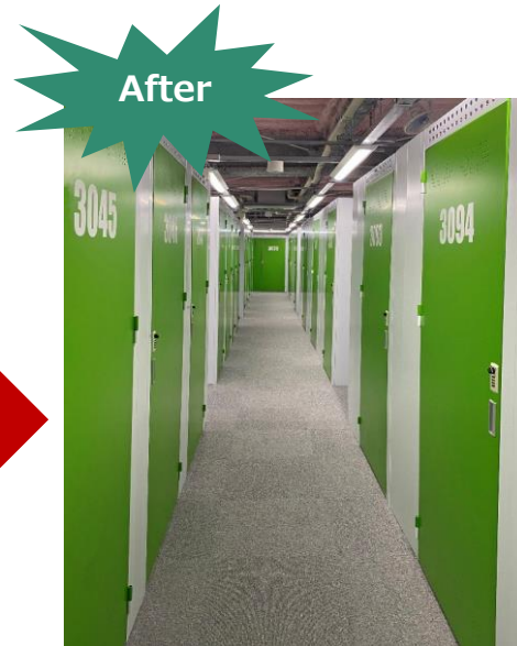
当社施工施設例
