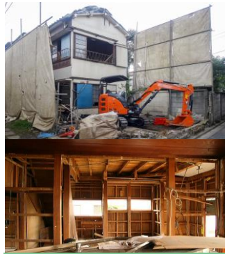
解体工事 不要物整理
