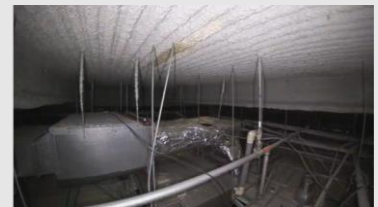
天井裏内部 (IBIS2撮影映像より抜粋)
