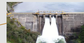
幌満川水力発電所
