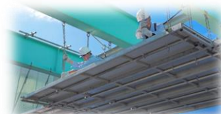
パネル式吊り棚足場 「SPIDER PANEL」
