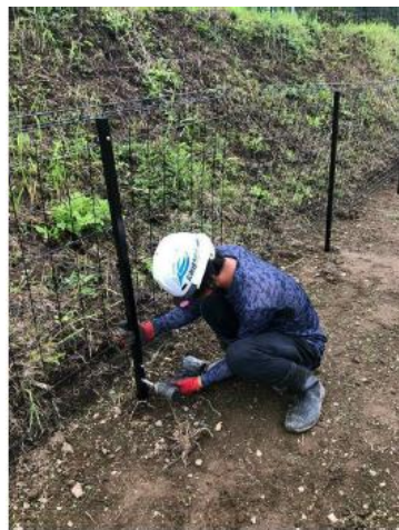
フェンスの設置や杭打ち等
