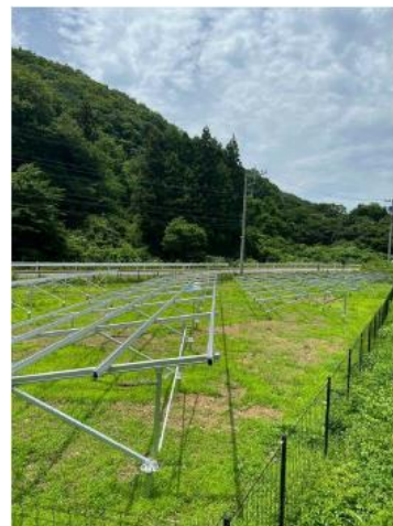
ケーブルや架台設置
