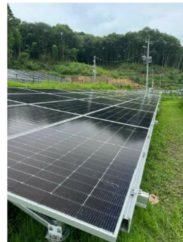
太陽光パネルの設置
