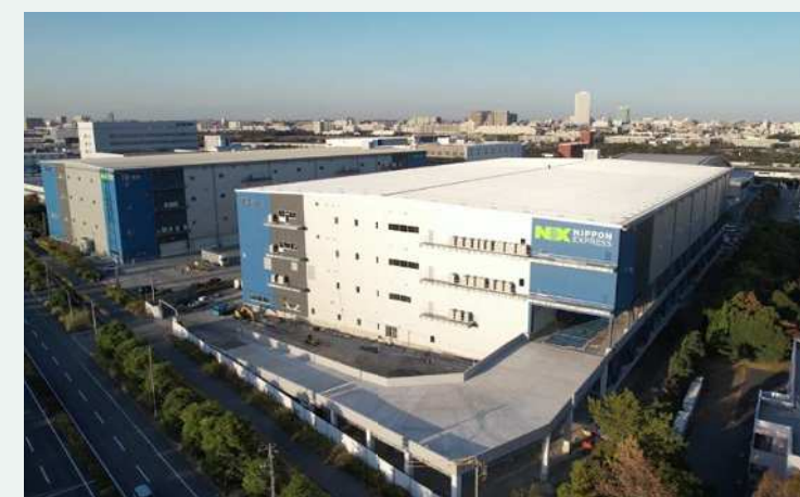
最新鋭の BTS 型倉庫（習志野地区倉庫）
