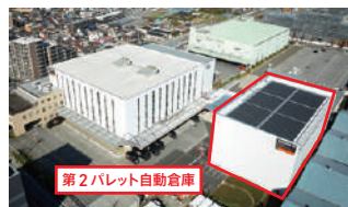
屋上には太陽光パネルを設置している第2パレット自動倉庫
