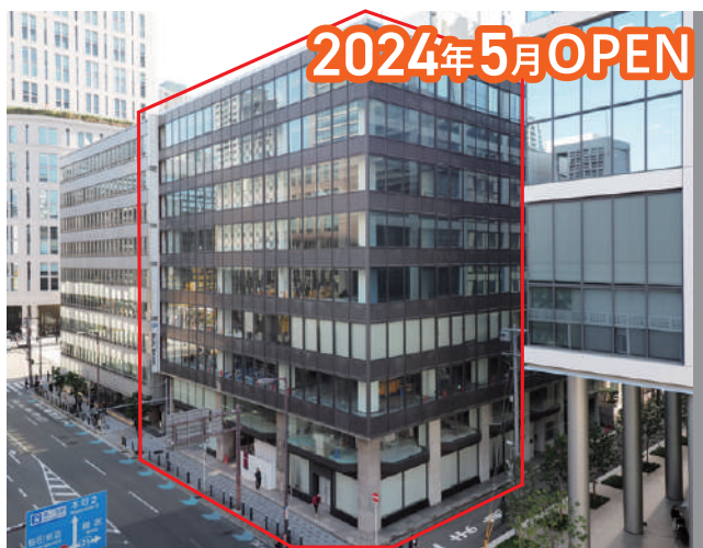
本町駅より徒歩1分のトラスコ セントラルビル
