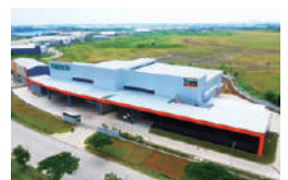
トラスコナカヤマインドネシア社屋 敷地面積:4,894坪(16,178㎡) 延床面積:3,155坪(10,430㎡)
