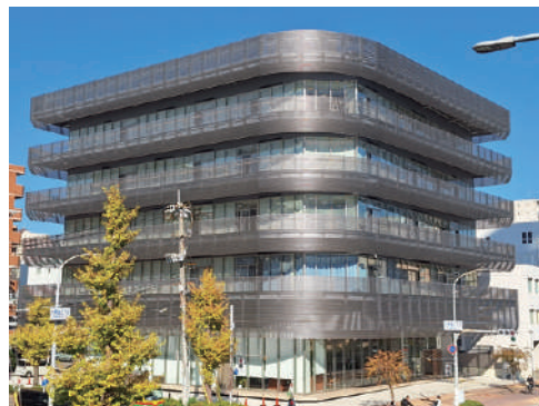
中山記念会館(令和3年(2021)9月15日竣工) 敷地面積: 424坪 延床面積: 1,728坪 建物構造: 地下1階、地上5階、柱頭免震
