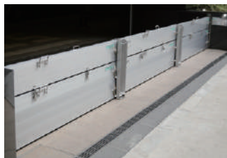
高さ1メートルの止水板
