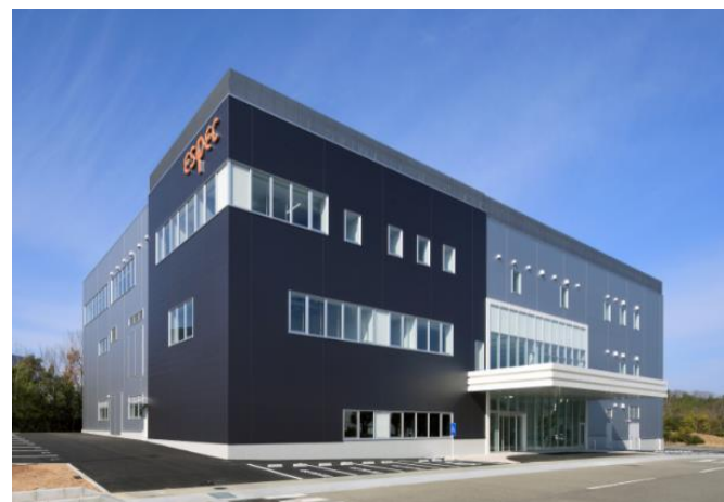
技術開発棟の外観
