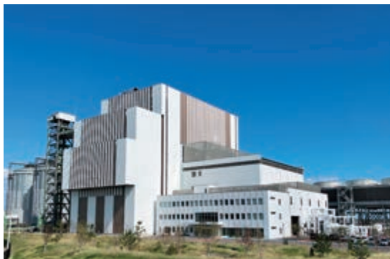
バイオマス発電プラント
