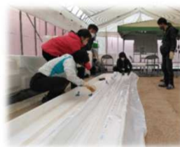
ベッドに、防水・給水・防根シートを張り、その上にバミスを敷き詰める
