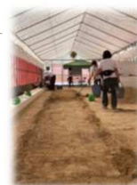
ベッドを設置する溝を掘り、地面を水平に整える
