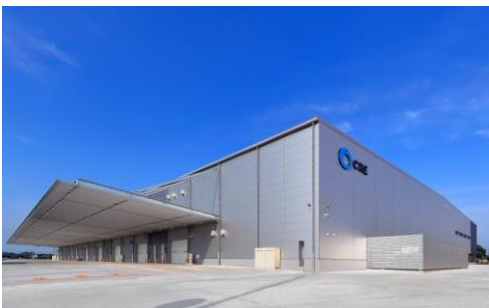
5 ロジスクエア羽生 2016年7月竣工
