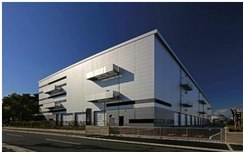
21 ロジスクエア伊丹 2022年11月竣工
