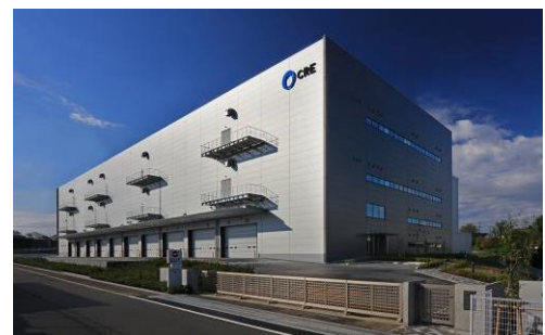
8 ロジスクエア新座 2017年4月竣工
