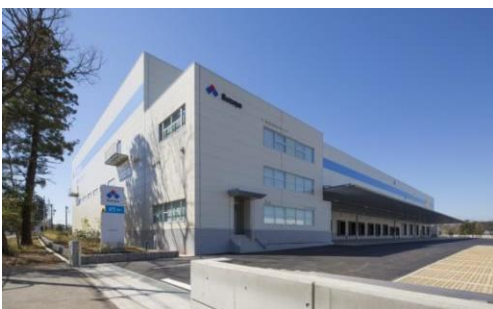
3 ロジスクエア日高 2015年3月竣工
