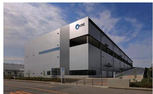
4 ロジスクエア久喜 2016年6月竣工
