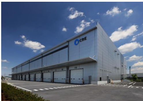
15 ロジスクエア川越Ⅱ 2019年6月竣工
