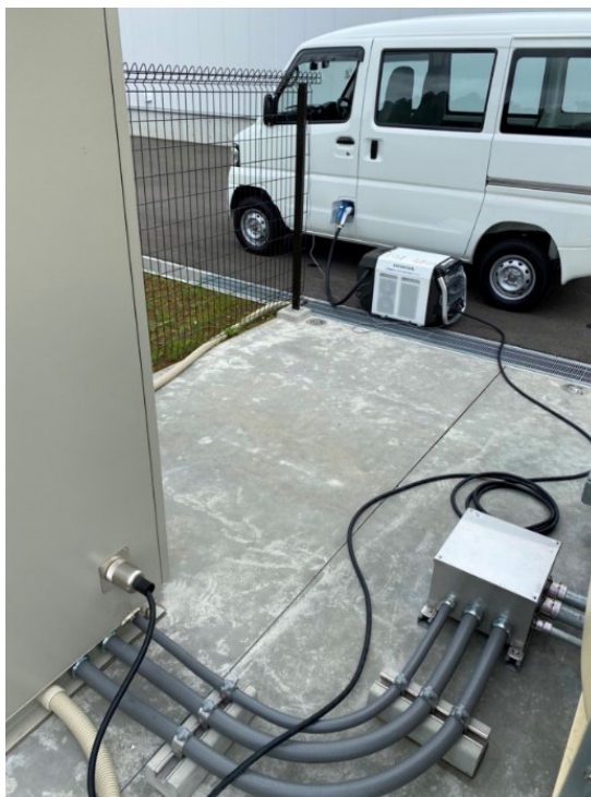
(左) 蓄電池から制御盤への電力供給の様子、(右) EV から制御盤への電力供給の様子
