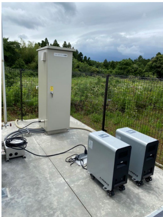
(左) 蓄電池から制御盤への電力供給の様子、(右) EV から制御盤への電力供給の様子
