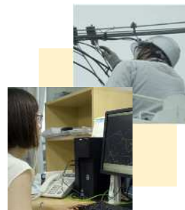
FTTH幹線工事
