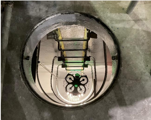
初めての操縦でも簡単に 狭い地下ピット内に入れることが可能
