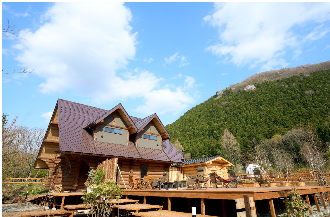
受付棟、パブリックサウナ外観
