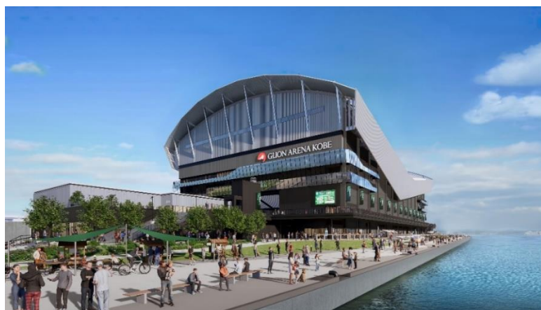
GLION ARENA KOBE 正面イメージ
