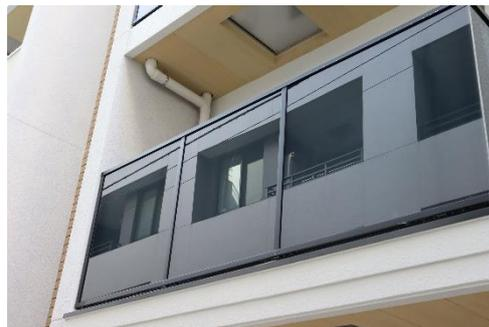
建物の正面から見た時に、大きく印象付けるバルコニー手摺部分には、2つのデザインを取り入れました。1つ目は、通常の「EL FARO」シリーズで使用している吹付塗装ではなく、日本の伝統的な建築物や和風の住宅で見られる漆喰壁を想起させる塗装を採用しました。2つ目は、モノクロ基調の“モダン”のイメージを連想させる黒いガラス手摺を採用しました。
