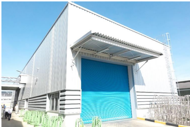
ニッケルメッキ工場建設 22年6月稼働
